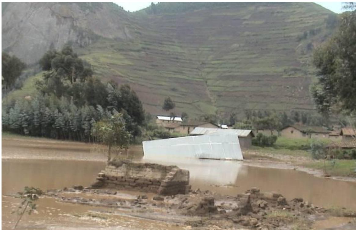
Figure 29: Crues subites avec de sérieux dégâts sur les vies humaines et les Infrastructures à Bigogwe dans le District de Nyabihu, Province du Nord
