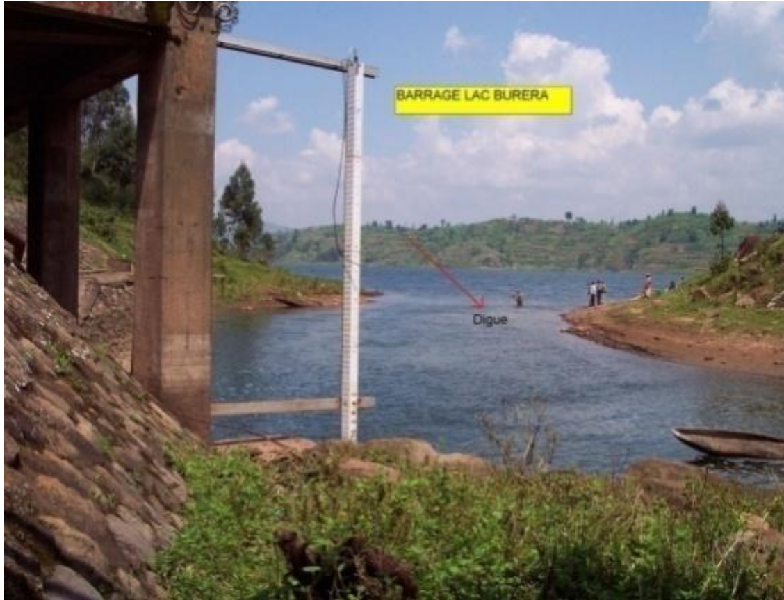
Figure 31: Baisse du niveau d'eau du lac Bulera alimentant les centrales hydroélectrique de Ntaruka et Mukungwa
